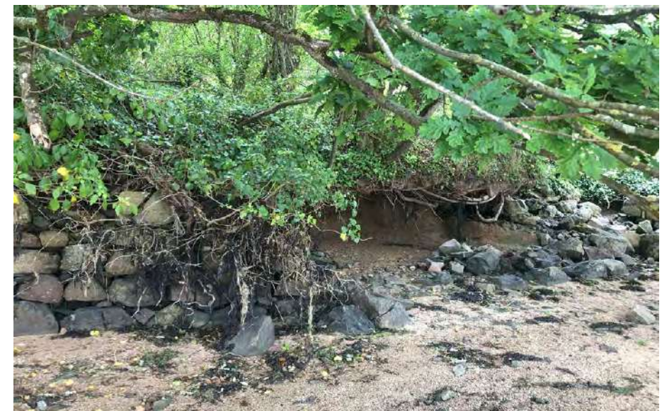
Soutènement ancien dégradé
