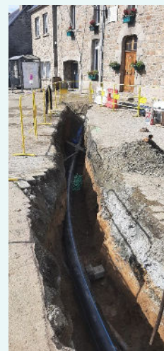
Réfection du réseau d'eau potable
