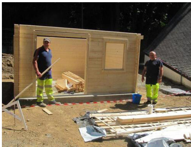
Le nouveau chalet du camping, installé par Pierrick Séguillon et Kevin Thomas, sans oublier Yvan Dudal pour la mise en place des réseaux et l'équipe des espaces verts pour l'aménagement paysager
