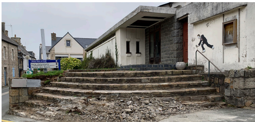
Démolition du boulodrome: premiers coups de pelle, donnés par Pierrick Séguillon avant les fêtes de Noël
