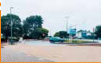
Aire intermodale de la Balise
