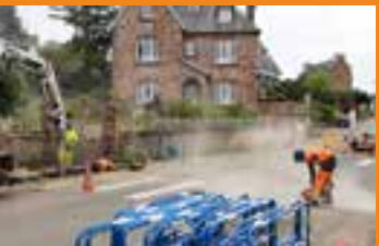
Rénovation du réseau d'eaux pluviales au port
