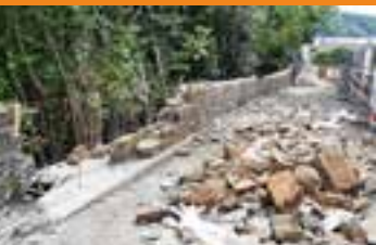
L'affaissement du mur rue du Trieux qui a nécessité la réfection complète de la chaussée
